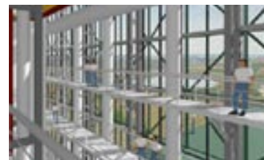
AmpliNett® som solavskjerming i fasade
