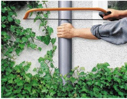
Heraussägen eines ca. 30 cm langen Fallrohrstückes
